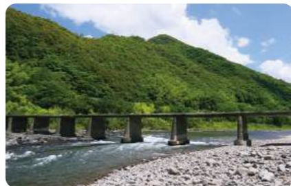
D 半家沈下橋 (四万十市) 半家駅から自転車で20分 増水時に川に沈むように設計された四万十川にかかる欄干のない橋。
